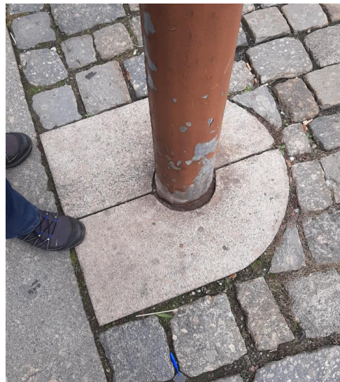
Detail stávající úpravy paty stožáru (bude zachováno)
